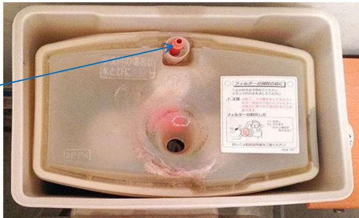
事例: トイレからの漏水状況を、確認したら、ここから、水が少しずつあふれ出ていました。ポータルタップの清掃とフィルターユニットの清掃により漏水は止まりました。
