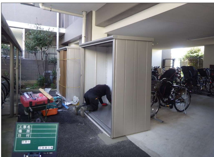
2019年度 台風15号被害復旧工事 倉庫復旧 作業中(新規組付)
