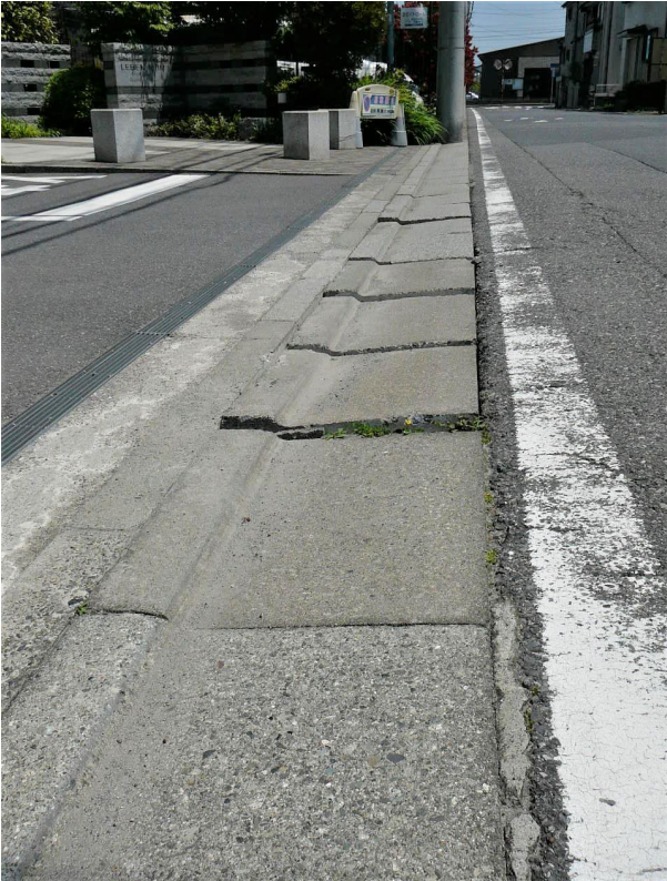
サブエントランス前の側溝の蓋(全景)
