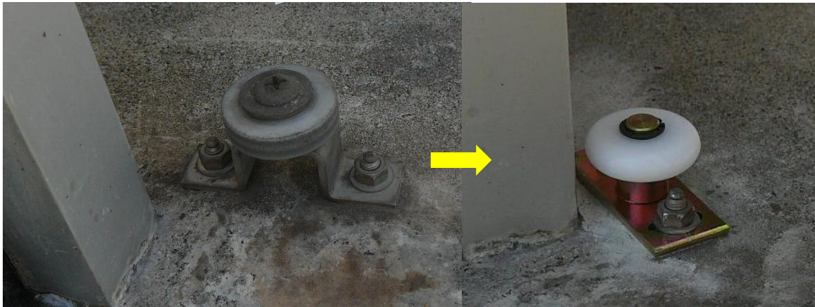
ガイドローラー(SUSガイドローラー)に交換
