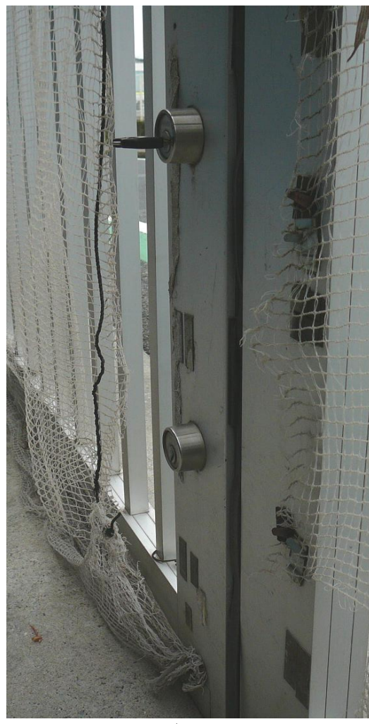
ガイドローラー(SUSガイドローラー)に交換
