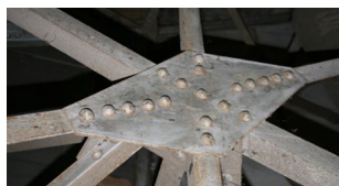
第二格納庫構造に採用された「ダイヤモンドトラス」ガセットプレート部
