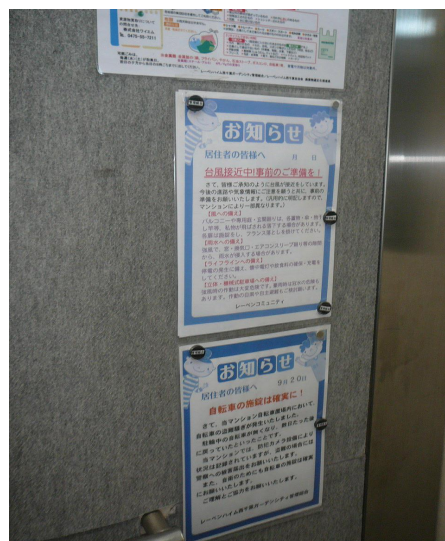
2. エレベータ内掲示の飛散防止 の為、マグネット追加。
