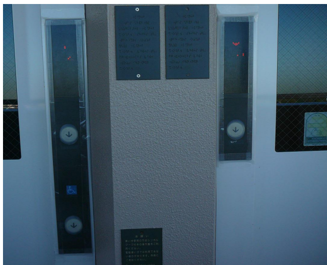
1. 雨水侵入による通電故障の対策として、 乗り場操作盤端部の養生テープによる目張り。
